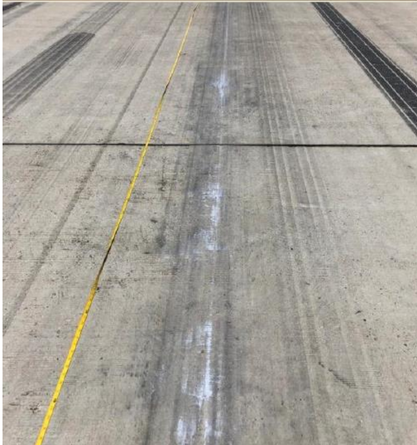
Oben: eine Überwachungskamera zeigt das feurige Schlittern über die Landebahn. Unten: Die Schleifspuren der Triebwerke begannen erst 4.500 Fuß jenseits der Schwelle (linkes Triebwerk) bzw. 5.500 Fuß (rechtes Triebwerk). Auf der Bahn wurden Triebwerksteile und Verkleidungen beider Motoren gefunden. 6
